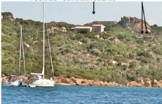
Constructions Guy Martinolle – Bunifaziu/Paraguano PC annulé – Démolition obtenue
